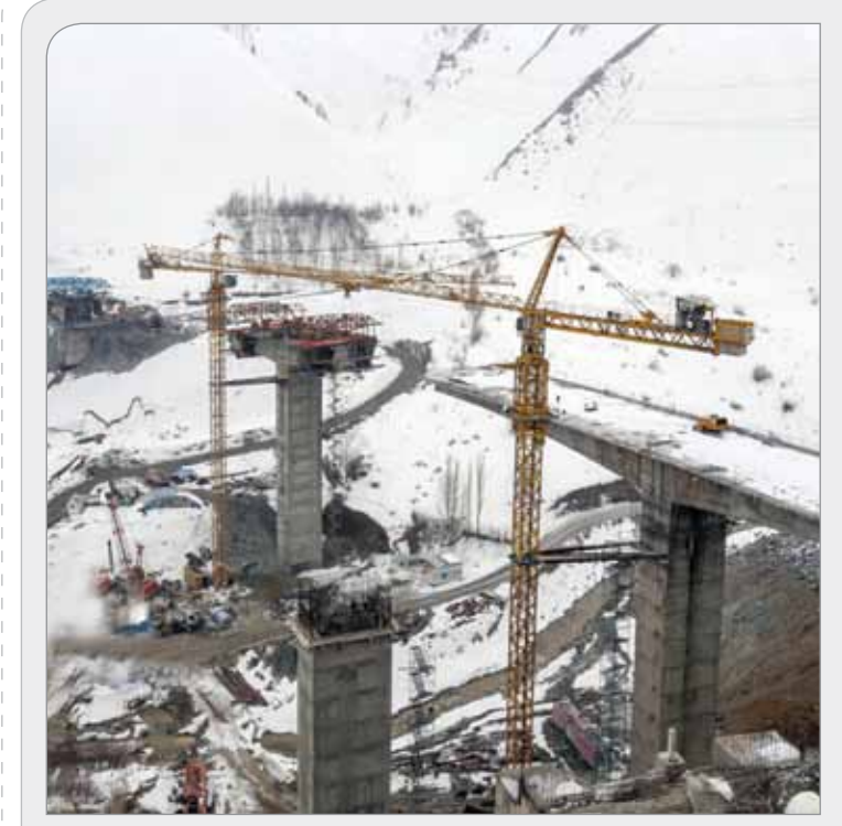
عملیات اجرایی منطقه ۲ آزادراه تهران - شمال عکس: ایرنا
